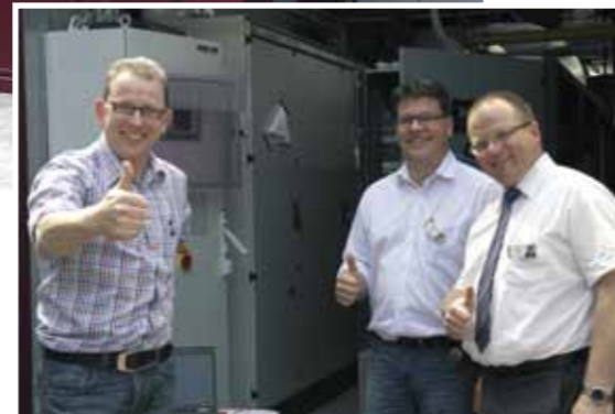
Daumen hoch für die gelungene Inbetriebnahme des BHKW in Pirmasens (v.r.n.l.): Verwaltungsdirektor Benno Lutz, der technische Leiter Andreas Heintz und FAMIS-Projektleiter Markus Reuter.
