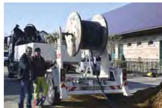
Andreas Windhäuser (l.) von FAMIS und Stephan Maaß von der VSE Verteilnetz bei der Leitungsverlegung auf dem Linslerhof.
