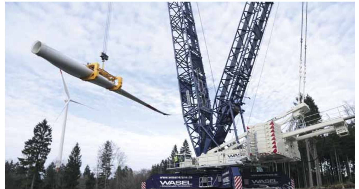
Spannende Angelegenheit: Die Montage einer Windkraftanlage.
