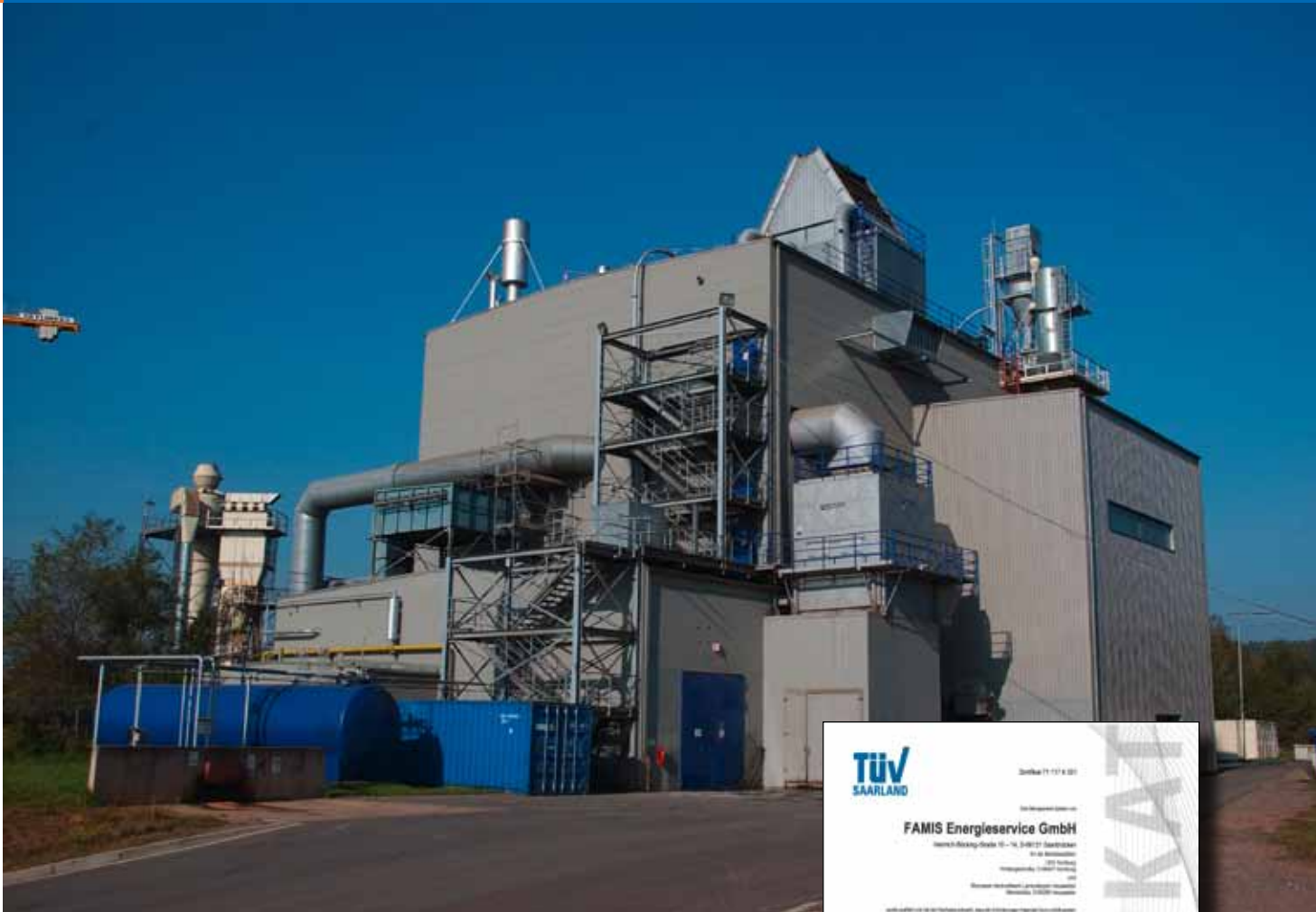
Das Biomasse-Heizkraftwerk im Laminare Park in Eiweiler wurde unter Federführung der FAMIS bereits zertifiziert.
